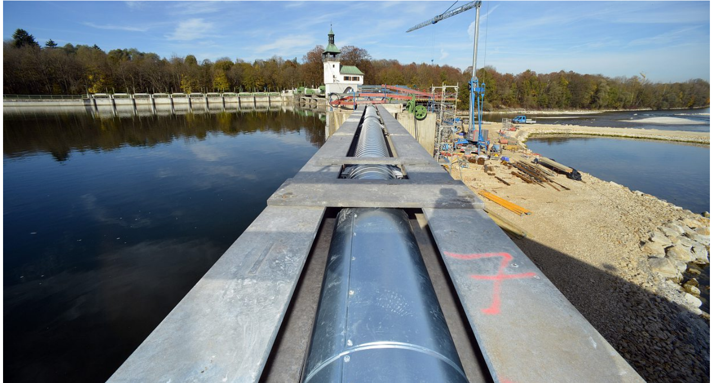
Die Sanierung des Hochablasssteges haben die Stadtwerke genutzt, um die 145 Meter lange Wasserleitung zu erneuern. Foto: swa/Hosemann
